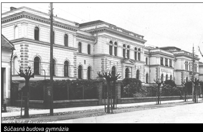
Súčasná budova gymnázia
