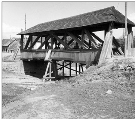
Zastrešená drevená lávka ponad Hornád
