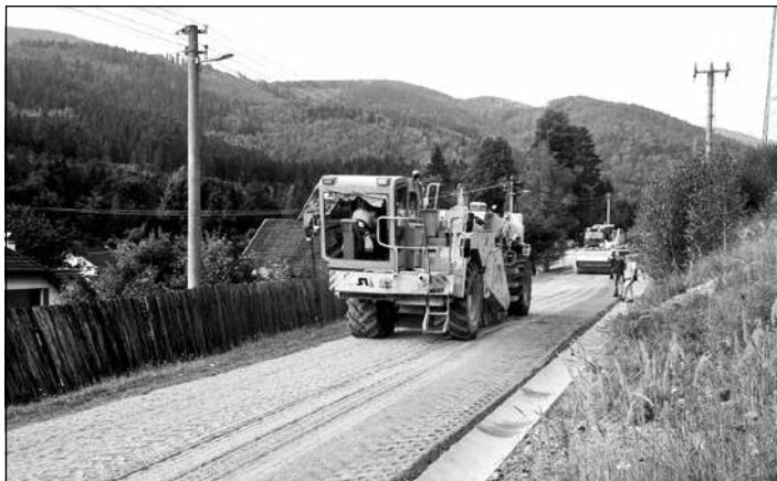
Spevnenie podkladu prefrézovaním s doplnením cementu pre vytvorenie stabilizačnej podkladnej vrstvy, realizácia odvodňovacieho systému, osadzovanie obrubníkov a pokládka asfaltových vrstiev na Rybničnej ul. v Novoveskej Hute.
