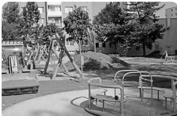
Výstavba detského ihriska Rodinka na sídl. Mier.
