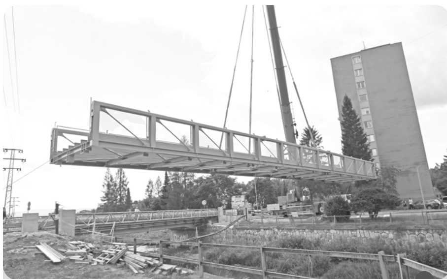
14. júla dopoludnia stavbári uložili konštrukciu novej lávky na Ulici Ing. O. Kožucha a následne realizovali ďalšie práce súvisiace s dokončením lávky i všetkých príslušných sietí. Zatažovacia skúška lávky bola naplánovaná na 20. augusta tohto roka.
