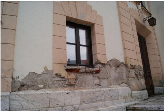
Lokálne poškodené obvodové murivá a štuková výzdoba západnej fasády divadelného úseku. / Južná fasáda divadelného úseku – olupujúci sa farebný náter na fasáde.
