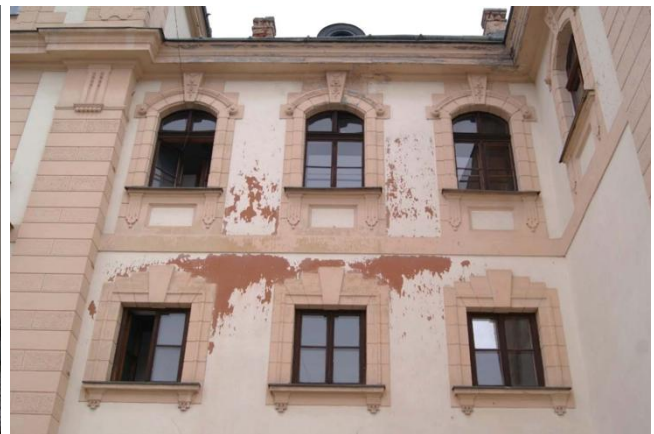
Lokálne poškodené obvodové murivá a štuková výzdoba západnej fasády divadelného úseku. / Južná fasáda divadelného úseku – olupujúci sa farebný náter na fasáde.
