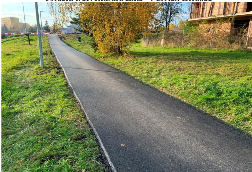
Obrázok č. 25: Rekonštrukcia – Nábřežie Hornádu
