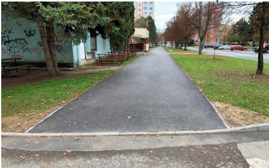
Obrázok č. 18: Rekonštrukcia – ul. Trieda 1. mája
