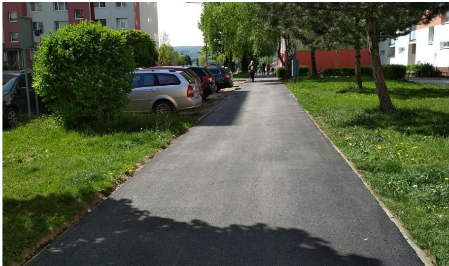
Obrázok č. 20: Rekonštrukcia – Kolárska ul.
