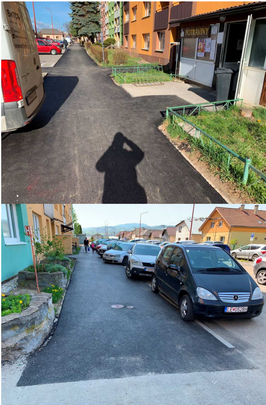
Obrázok č. 34: Rekonštrukcie chodníkov
